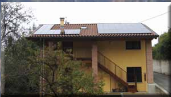
Impianto su Casa Pietro Lato sud-ovest
